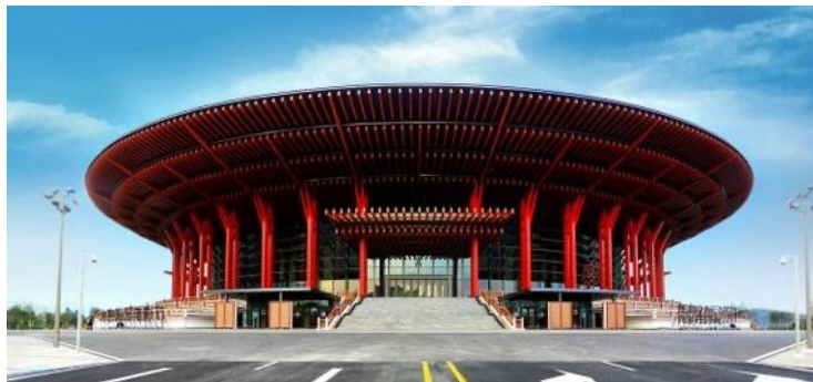
北京APEC怀柔会展中心会议厅装饰木作工程
